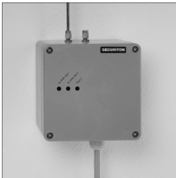
Das neue Transafe ADW 511 für Sonderbrandmeldung vereinigt ein bewährtes Produktkonzept mit den neusten Entwicklungen in der Sensorik und Mikroprozessor-technik. Durch vollelektronische Messzellen und eine mikroprozessor-gesteuerte Auswertung wird ein anwendungsspezifisch programmierbares Ansprechverhalten erreicht. Damit werden die Einsatz-möglichkeiten des ADW erheblich erweitert und universeller gestaltet.
